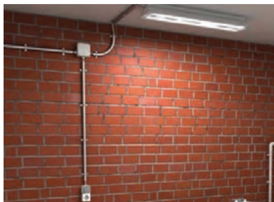
شکل ۳-۳۲- نمونه‌هایی از سیم‌کشی روکار
